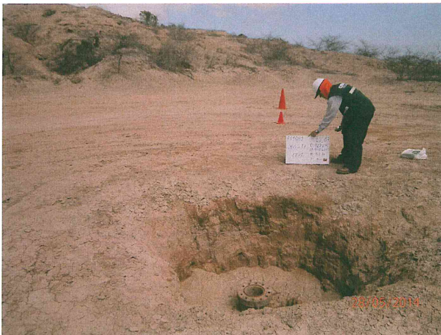
Fotografía N° 1. Vista donde se observa el pozo con el casing corroído y unido a una brida en el interior de un hoyo.
