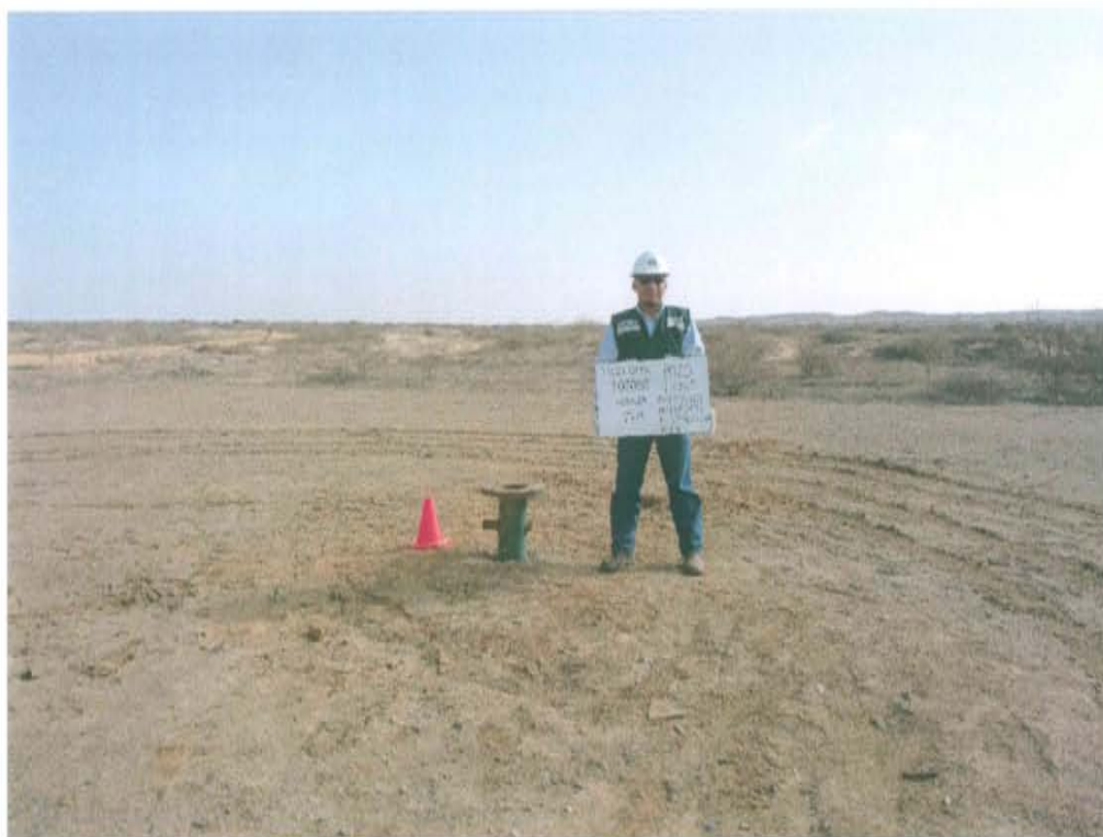
Fotografía N° 1. Identificación del pozo inactivo con código PERUPETRO T2365. Presenta casing con tapa de brida adaptadora con salidas laterales y expuestas a la intemperie.
