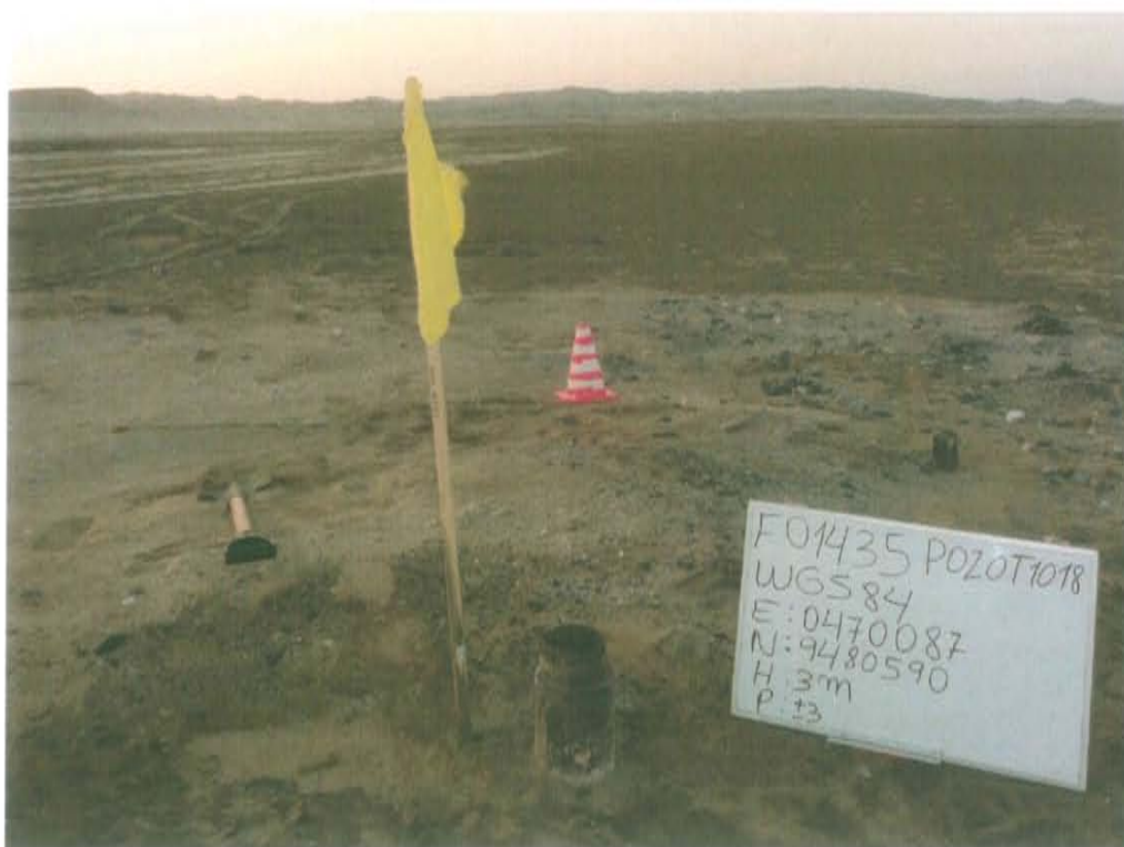
Fotografía N° 1. Identificación del pozo inactivo con código PERUPETRO T1018. Presenta casing abierto al ambiente.
