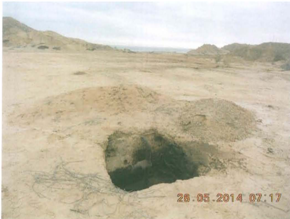
Fotografía N° 1. Vista panorámica del pozo T4890, ubicado sobre un terraplén afirmado sin acceso vehicular directo y vegetación escasa.
