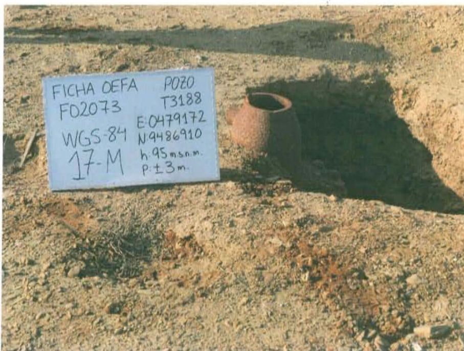
Fotografía N° 2. Se aprecia casing abierto, sin elementos de cierre en superficie que garanticen un cierre hermético del pozo.
