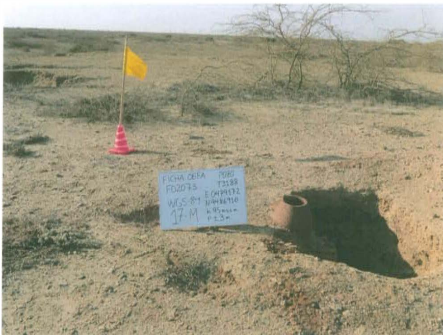
Fotografía N° 1. Se observa pozo inactivo expuesto al ambiente, en el interior de un hoyo.
