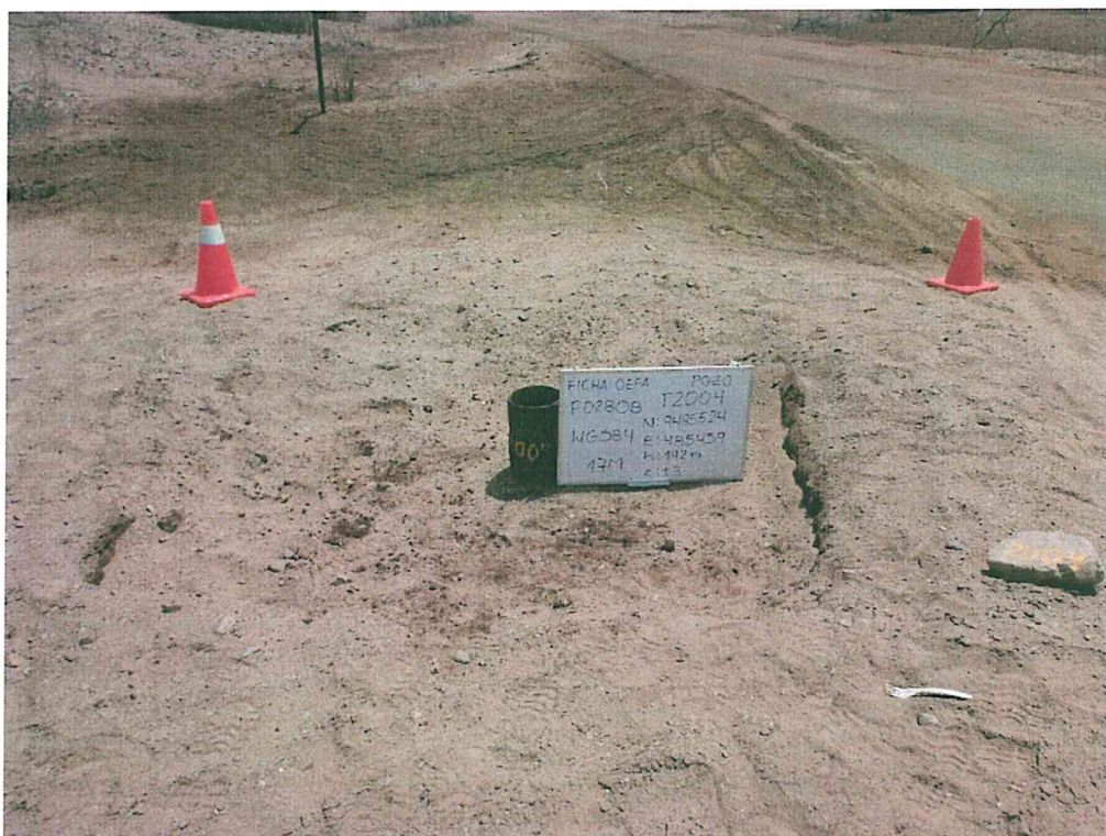
Fotografía N° 1. Identificación del pozo inactivo con código PERUPETRO T2004. Presenta casing que sobresale del interior de una excavación (con arena en su interior) sin elementos de cierre que aseguren su hermetismo por lo que se consideran abiertos y expuestos al ambiente.
