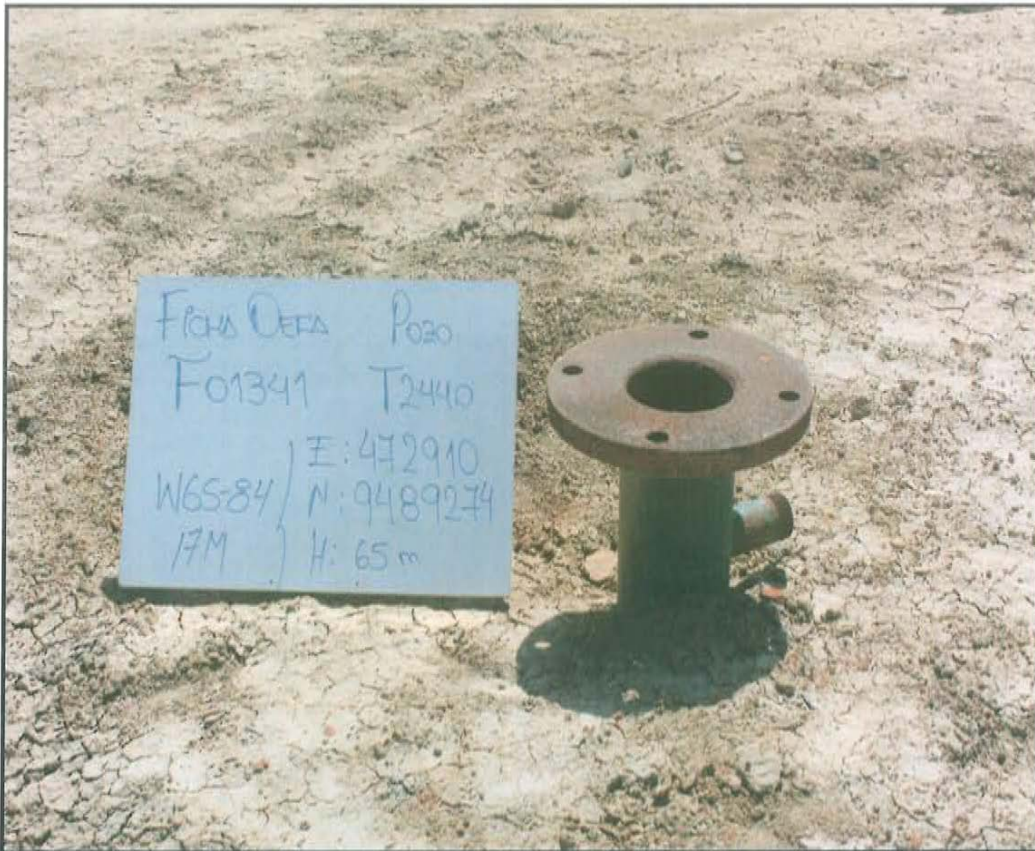
Fotografía N° 1. Pozo T 2440 presenta cabezal de pozo que emerge a una altura de 0,3 m desde la superficie del suelo y cuenta con un tubo de salida lateral de 2 plg.
