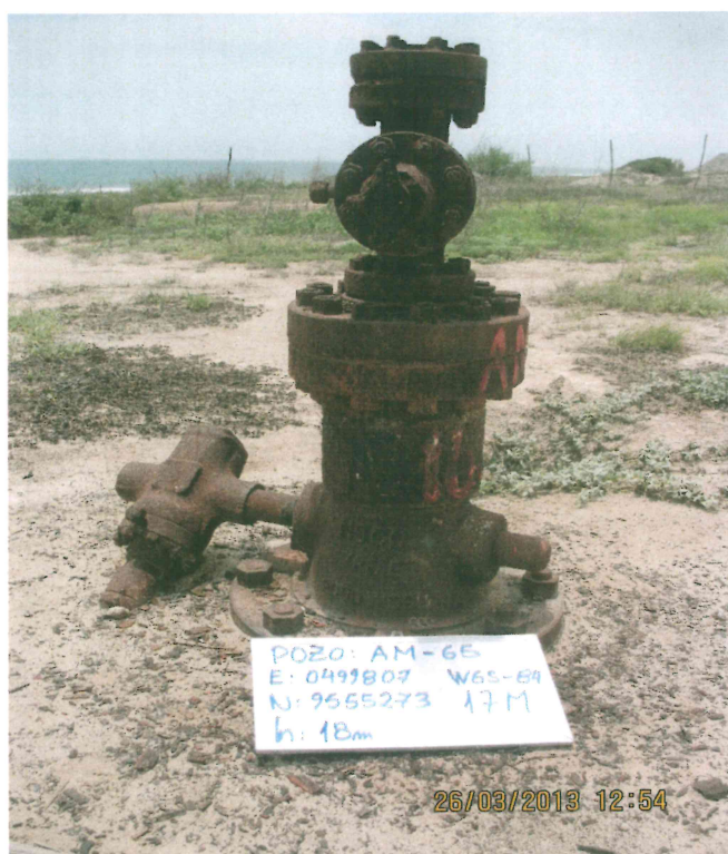
Fotografía N° 1. Se observa pozo inactivo expuesto al ambiente en estado de corrosión avanzado.
