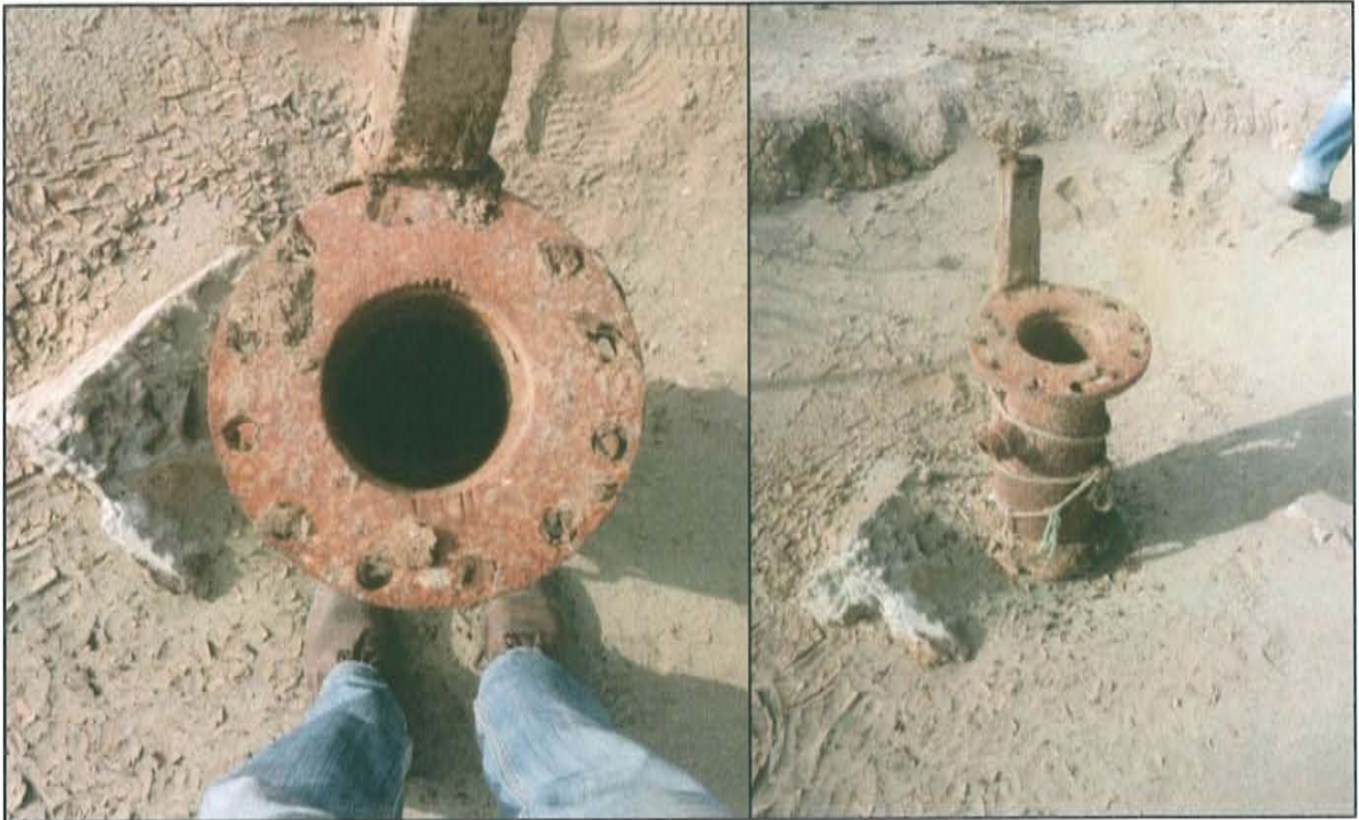
Fotografía N° 1. Pozo con código PETRUPETRO T2158 inactivo mal abandonado, donde se observa el casing con brida y estaca de madera sujeta al pozo.
