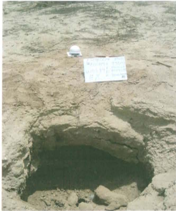
Fotografía N° 01.- Pozo con código PERUPETRO T5043 y con código Ficha OEFA F00897, se observa el casing del pozo dentro de un hoyo, asimismo, no cuenta con cabezal ni con alguna válvula de cierre por lo que se encuentra expuesto al ambiente.
