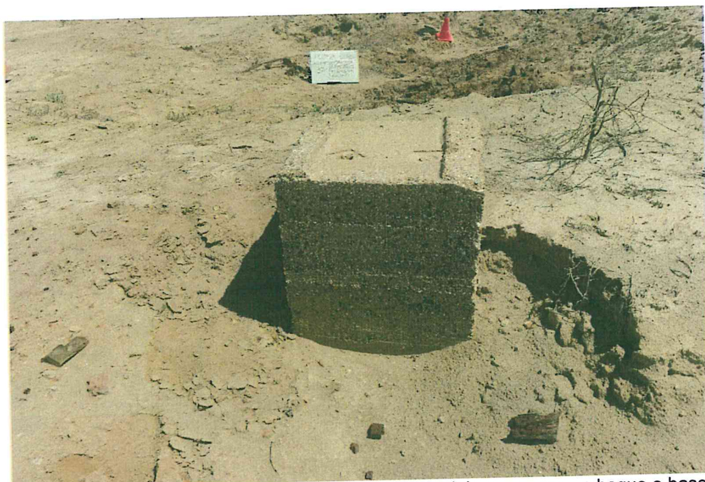
Fotografía N° 1. Se observa indicios de la existencia del pozo como un bloque o base de concreto utilizados en la actividad de hidrocarburos.
