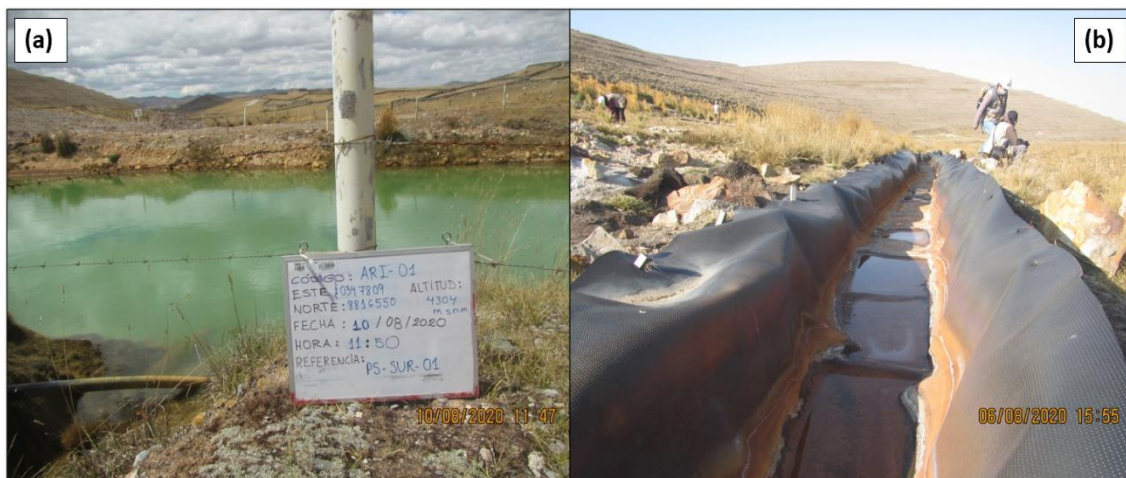
Figura 7.36. a) Poza de sedimentación PS-SUR-01 sin recubrimiento de geomembrana, y b) canal de coronación sur
