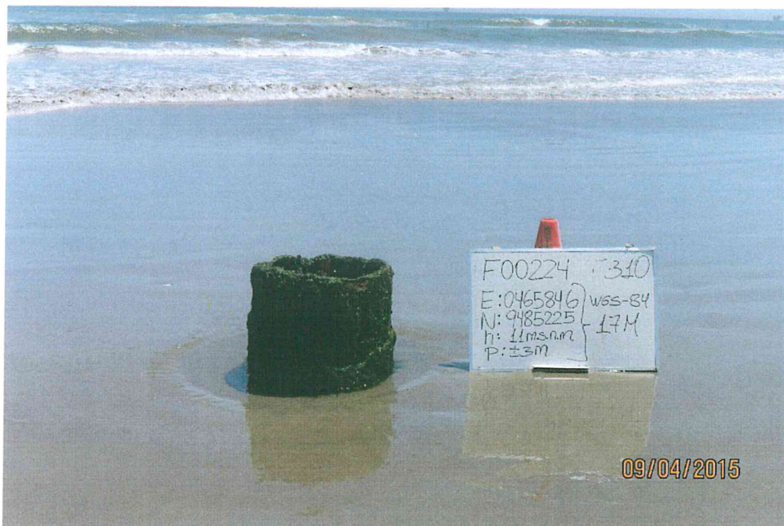
Fotografía N° 1. El Pozo T_310 presenta casing abierto y expuesto al ambiente.
