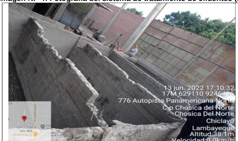
Imagen N.º 4: Fotografía del sistema de tratamiento de efluentes (1)
