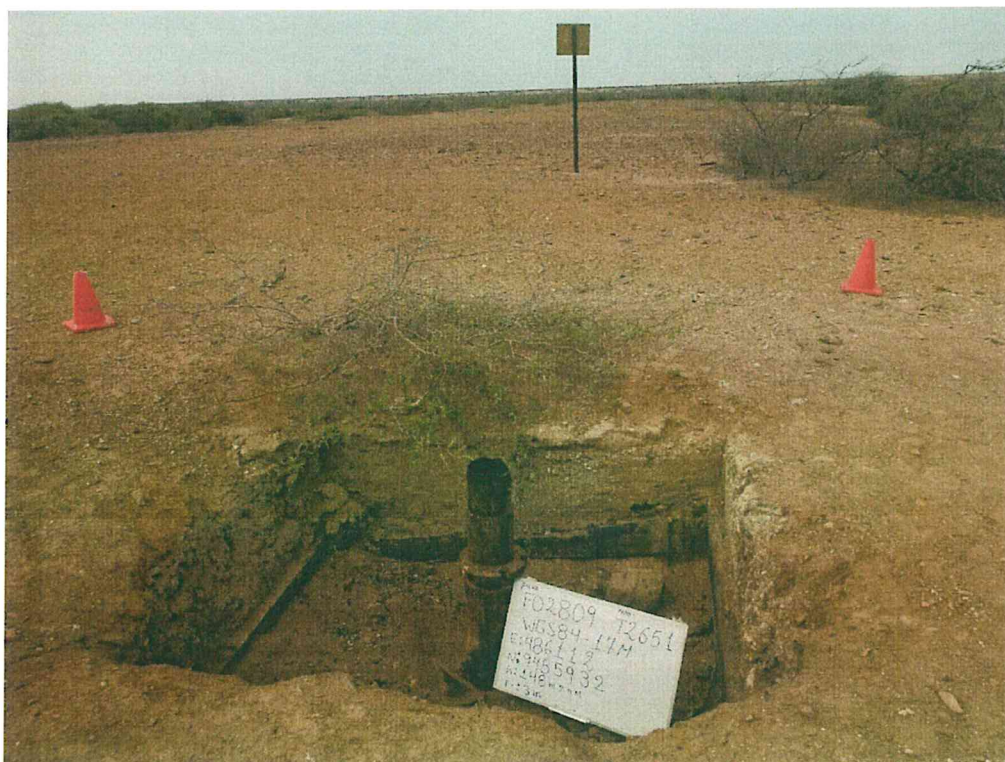
Fotografía N° 1. Identificación del pozo inactivo con código PERUPETRO T2651. Presenta casing descubierta en el interior de una excavación de sección rectangular y que cuenta con letrero.
