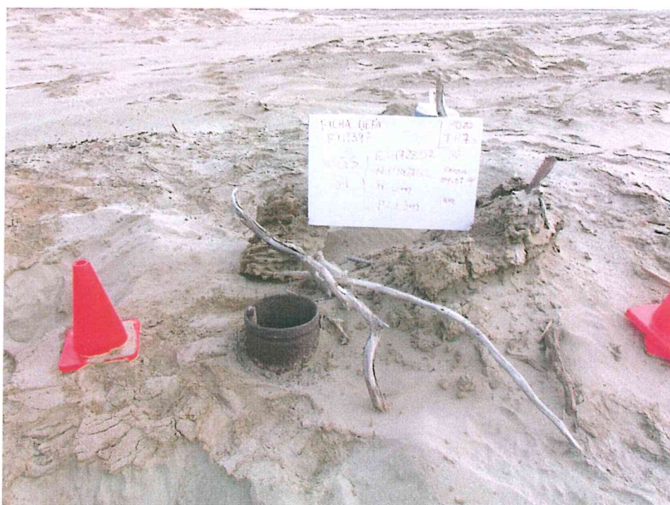
Fotografía N° 2. Se observa casing oxidado, abierto y expuesto al ambiente, de cuyo interior sobresale una varilla corrugada oxidada.
