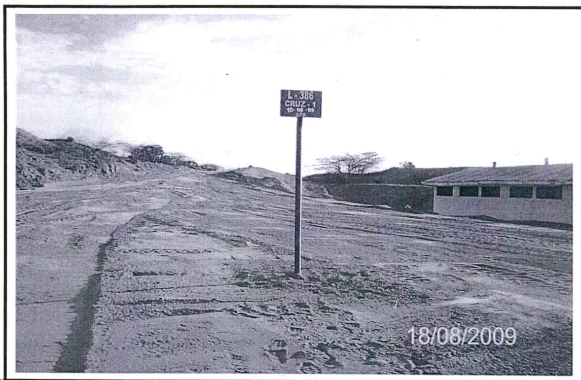
Foto 8 Vista panorámica del Pozo L-386 Cruz 1 concluido, mostrando terraplén limpio, tubo de 2 mts y letrero según reglamento.
