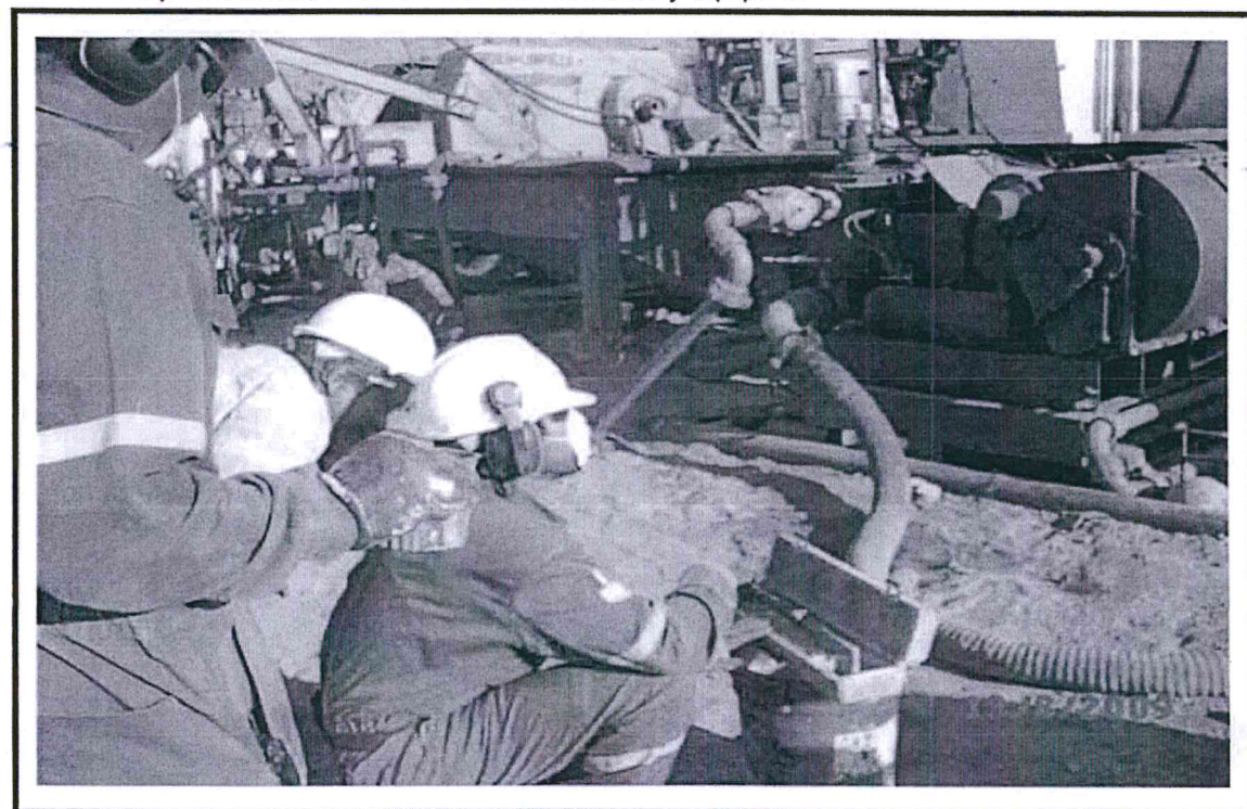
Foto 6. Midiendo densidad de lechada de cemento.
