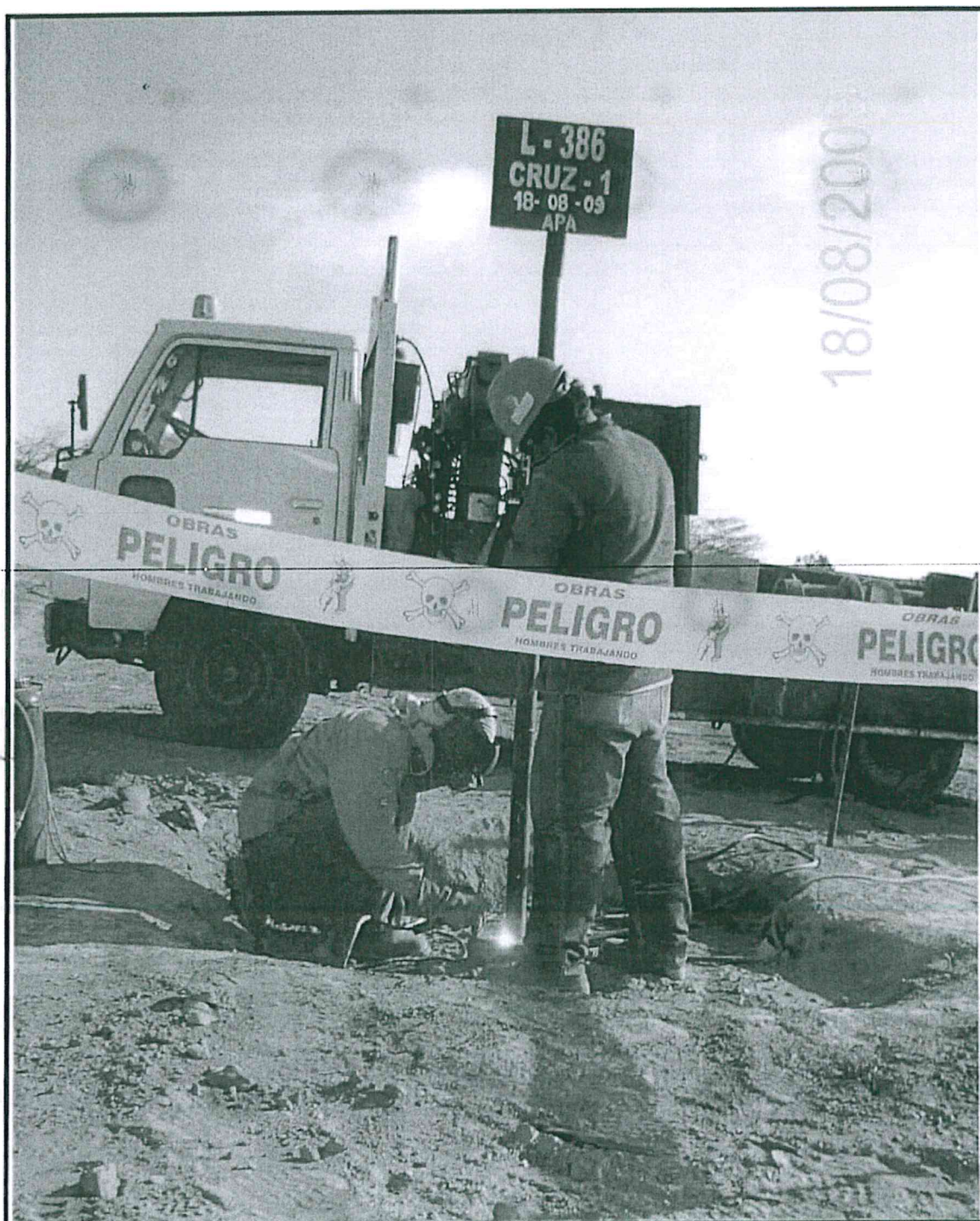
Foto 7. Después de la cementación, soldó plancha que tapa el pozo y colocó encima tubo de 2.00 m de altura con letrero.
