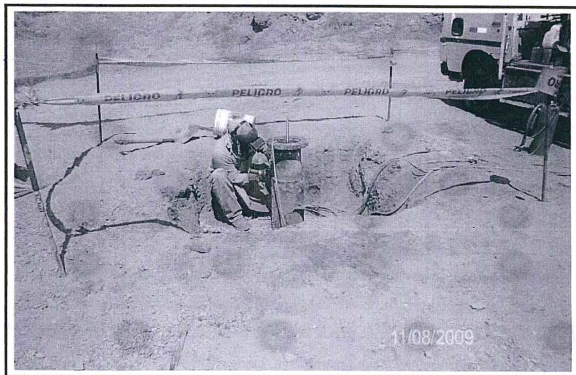
Foto 2. Excavó cantina, cortó forro de 10 5/8" OD, acondicionó y soldó encima extensión con brida en tope.
