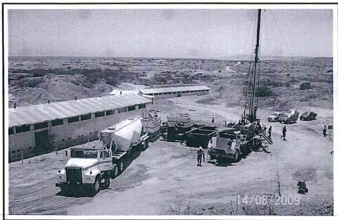
Foto 5. Momentos durante la cementación. Obsérvese mezclador (mixer), bomba, tanque de desplazamiento, camión "bulk" con cemento y equipo 3.
