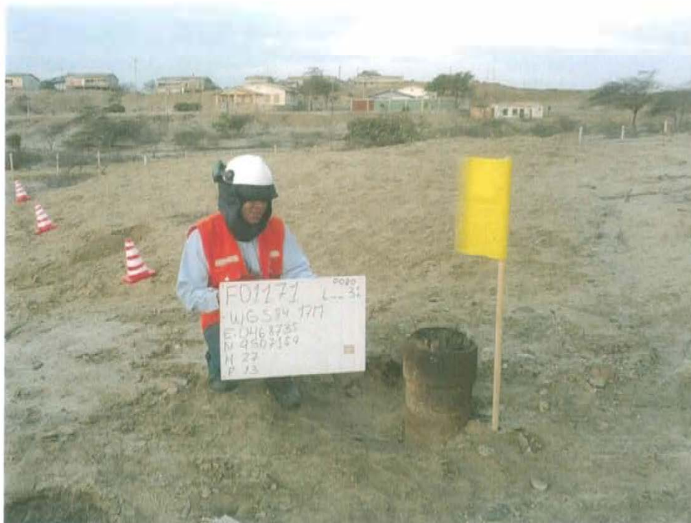
Fotografía N° 1. Identificación del pozo inactivo con código PERUPETRO L_31. Presenta casing sin válvulas con tapón de madera en la superficie.
