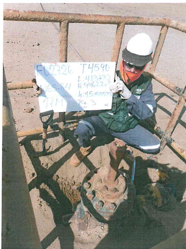
Fotografía N° 2. Coordenada de ubicación del pozo T4590, ubicado en el interior de un cerco metálico.
