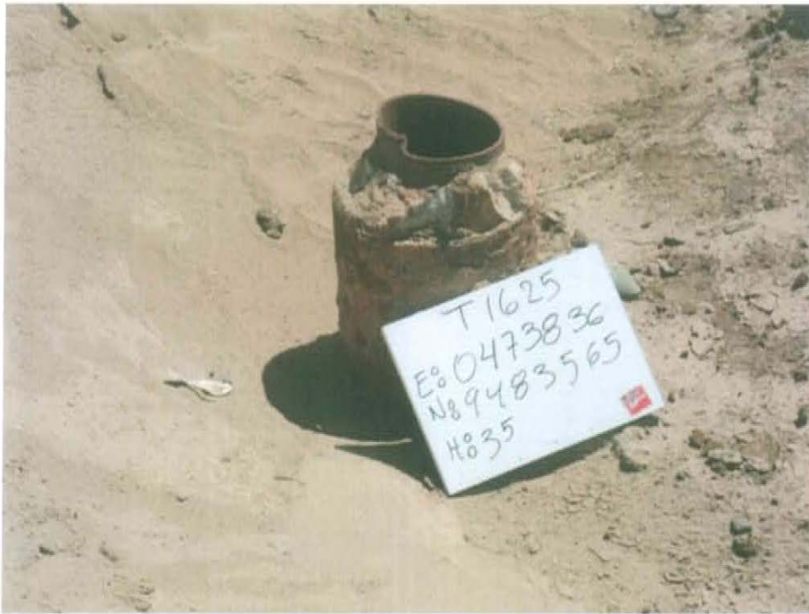
Fotografía N° 1. Pozo inactivo con código PERUPETRO T1625, sin cabezal posee dos casing concéntricos cementado en el espacio anular.
