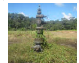
Vista donde se aprecia el pozo DORI-12 ubicado en la plataforma C.
