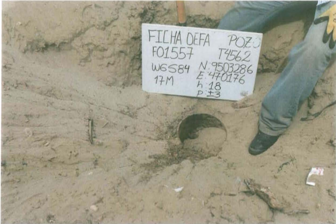
Fotografía N° 1. Identificación del pozo inactivo con código PERUPETRO T4562. Presenta casing abierto apenas visible debido al deslizamiento de material (arena) de las paredes laterales descubierta en una excavación donde se observó residuos peligrosos.
