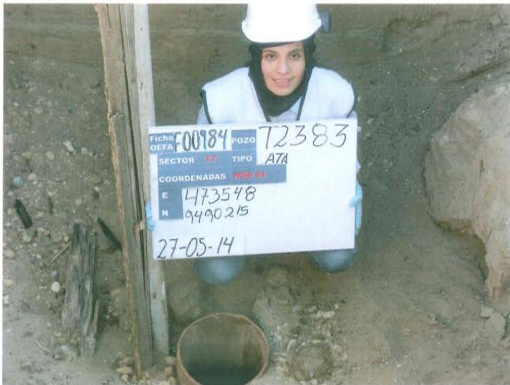
Fotografía N° 1. Identificación del pozo inactivo con código PERUPETRO T2383 que presenta casing sin cabezal.
