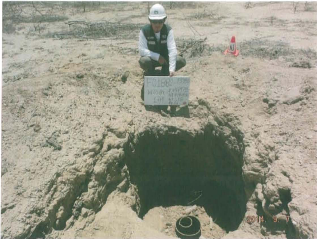
Fotografía N° 1. Pozo inactivo en terreno no habilitado, se encuentra dentro de hoyo de aproximadamente 1,70 m, no posee cabezal solo se observa dos casing concéntricos a nivel del suelo.
