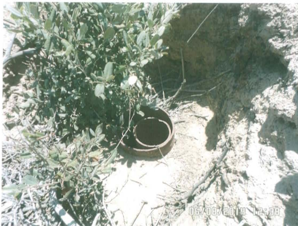
Fotografía N° 1. Vista pozo T3954 ubicado sobre una loma, se observa el casing posiblemente cortado.
