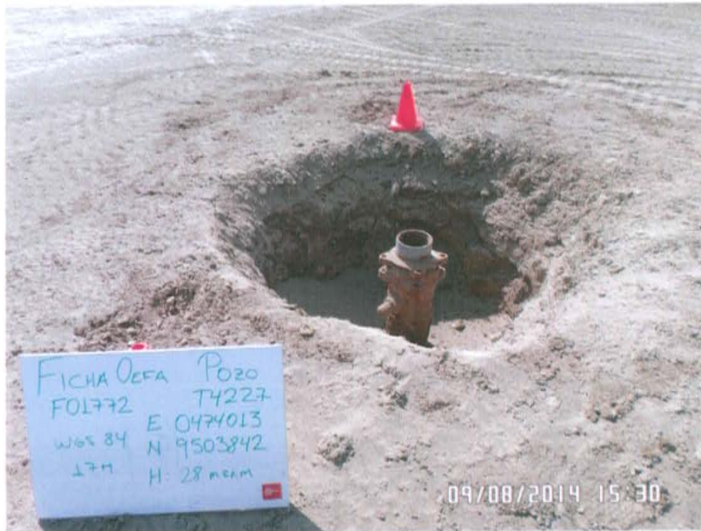
Fotografía N° 1. Vista pozo T4227 ubicado en una planicie adyacente a la vía de acceso.
