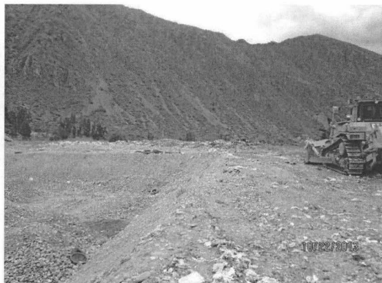
Foto 24: Equipo mecánico nivelando la superficie del sitio de disposición final
