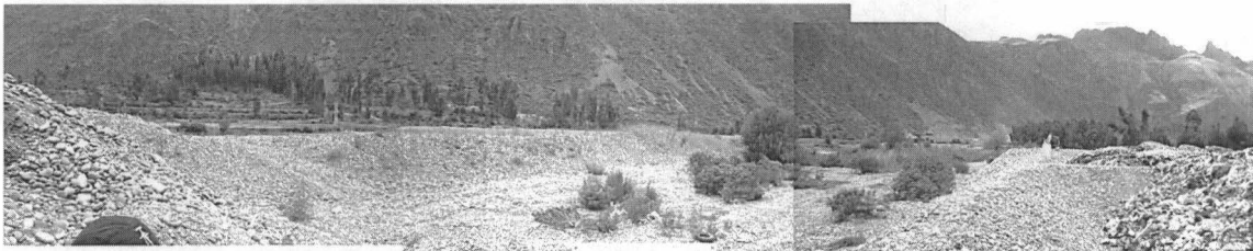
Foto 28: Celda secundaria para disposición de residuos sin uso, la vegetación (síntoma de aguas subterráneas) crece sobre el fondo de la celda, al costado derecho los residuos sin coberturar
