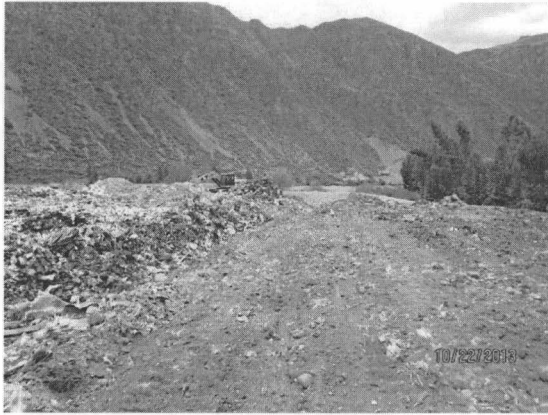
Foto 25: Los residuos son empujados hacia una celda al fondo del sitio, quedando residuos a los lados
