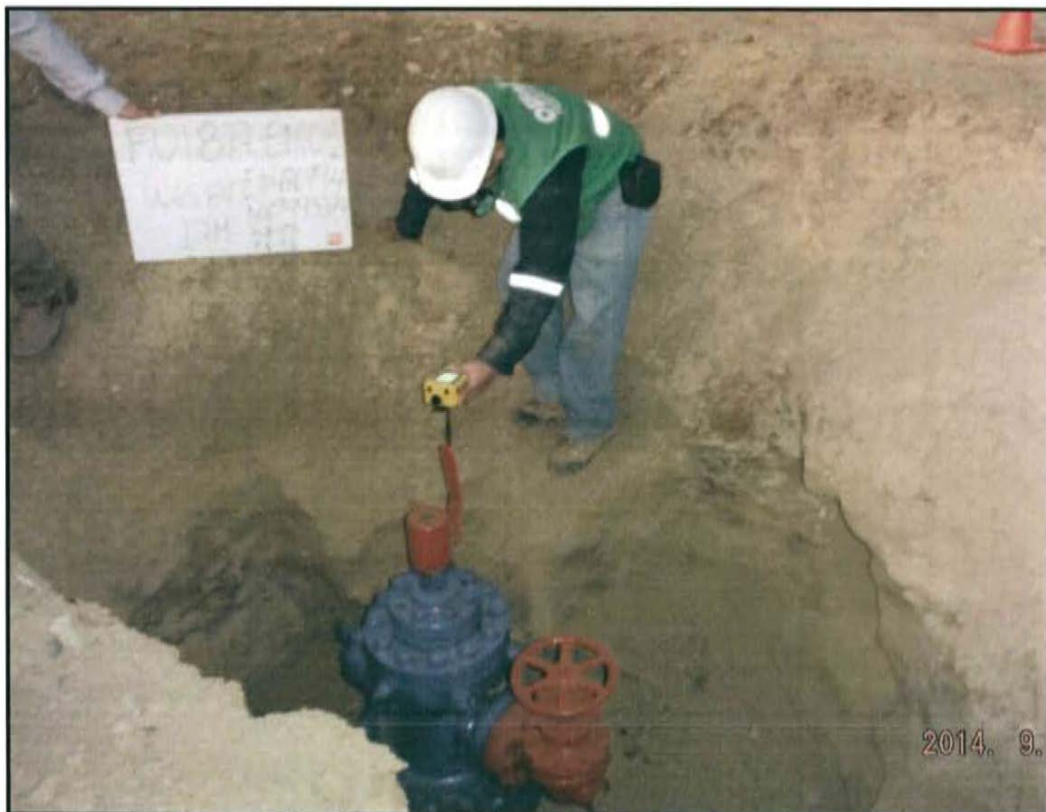
Fotografía N° 4. Medición de emisiones fugitivas en boca de pozo T3600.
