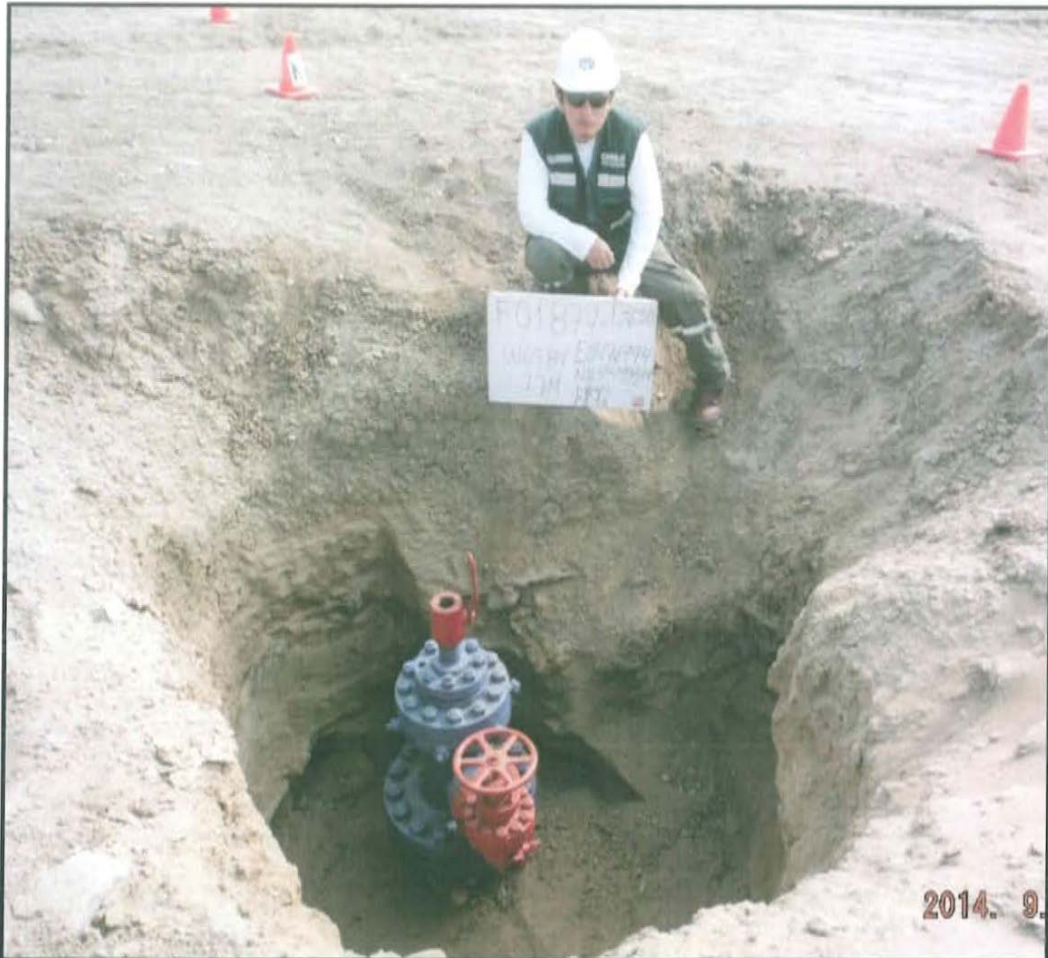
Fotografía N° 1. Pozo inactivo se encuentra dentro de hoyo, se observa cabezal del pozo con bridas y válvulas concentrica y lateral.
