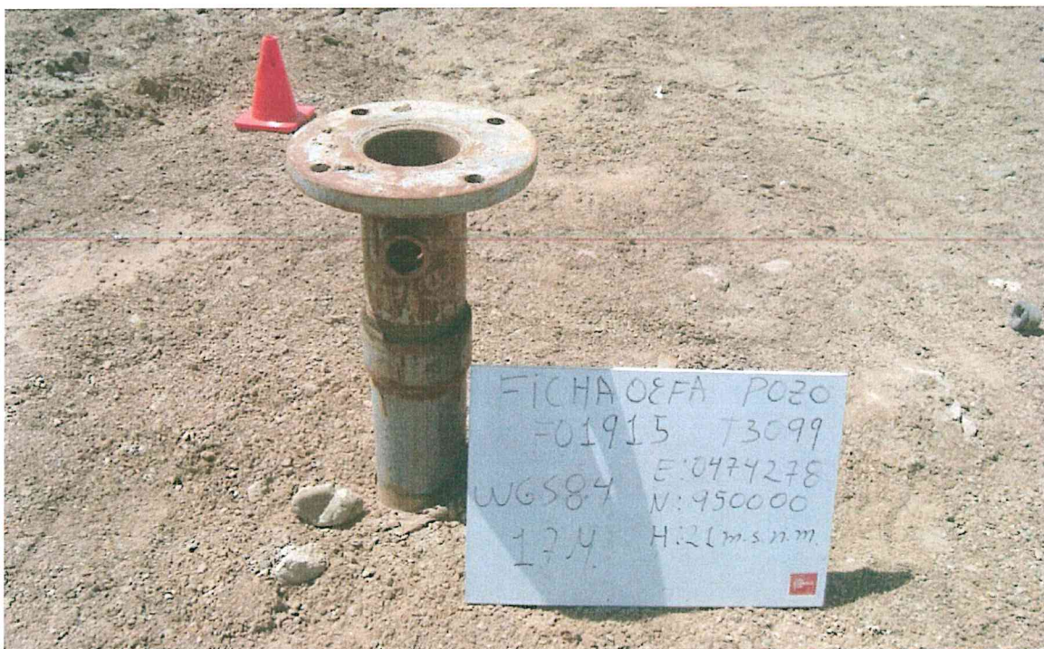
Fotografía N° 1. Pozo con código PERUPETRO T3099 y código Ficha OEFA F01915, se observa el casing con dos salidas laterales y unido a un cabezal compuesto por una (1) brida; sin embargo al no presentar algún elemento de cierre se encuentra abierto al ambiente.
