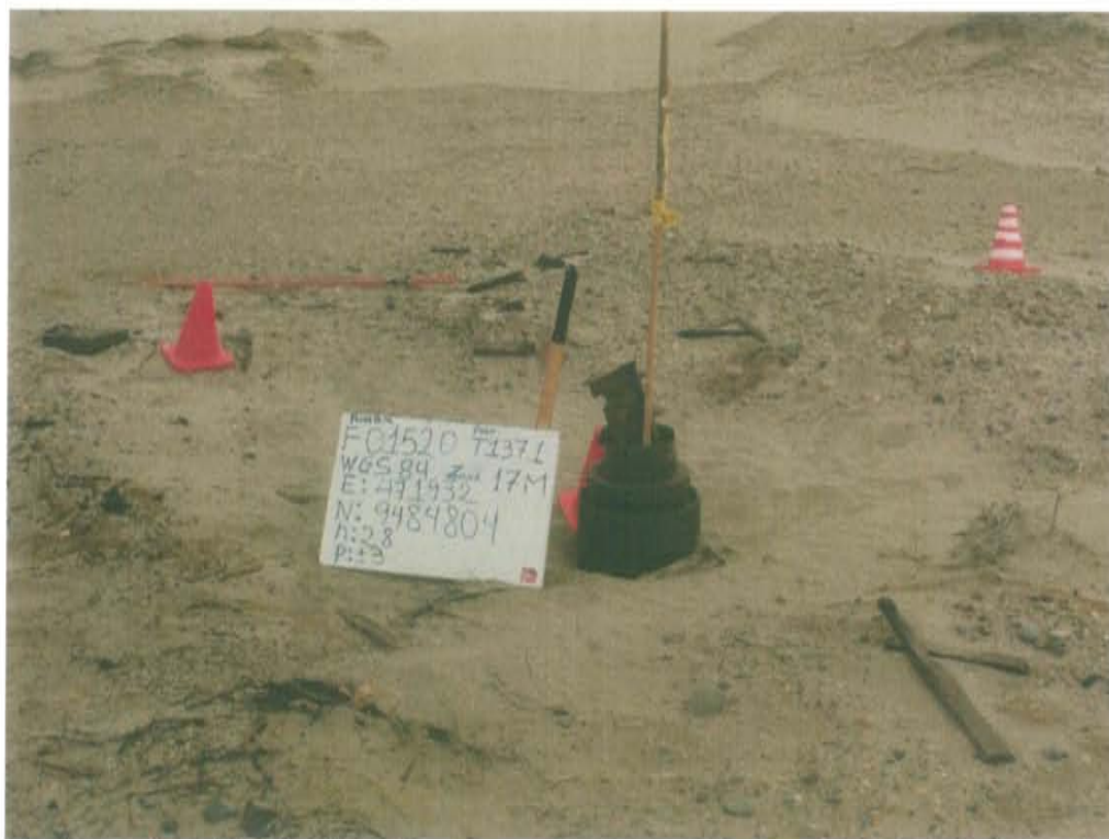
Fotografía N° 1. Identificación del pozo inactivo con código PERUPETRO T1371. Presenta casing corroído lleno de arena.
