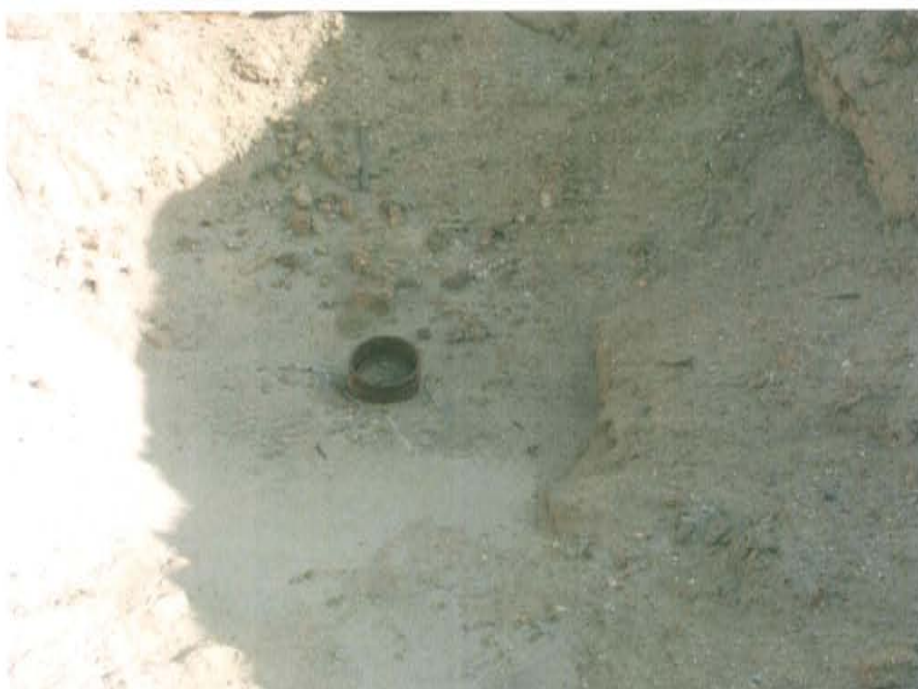
Fotografía N° 1. Vista del estado actual del pozo con código T1839 presenta tubería de revestimiento de 11 pulgadas y tubería de producción de 8 pulgadas con el interior cubierto de arena.
