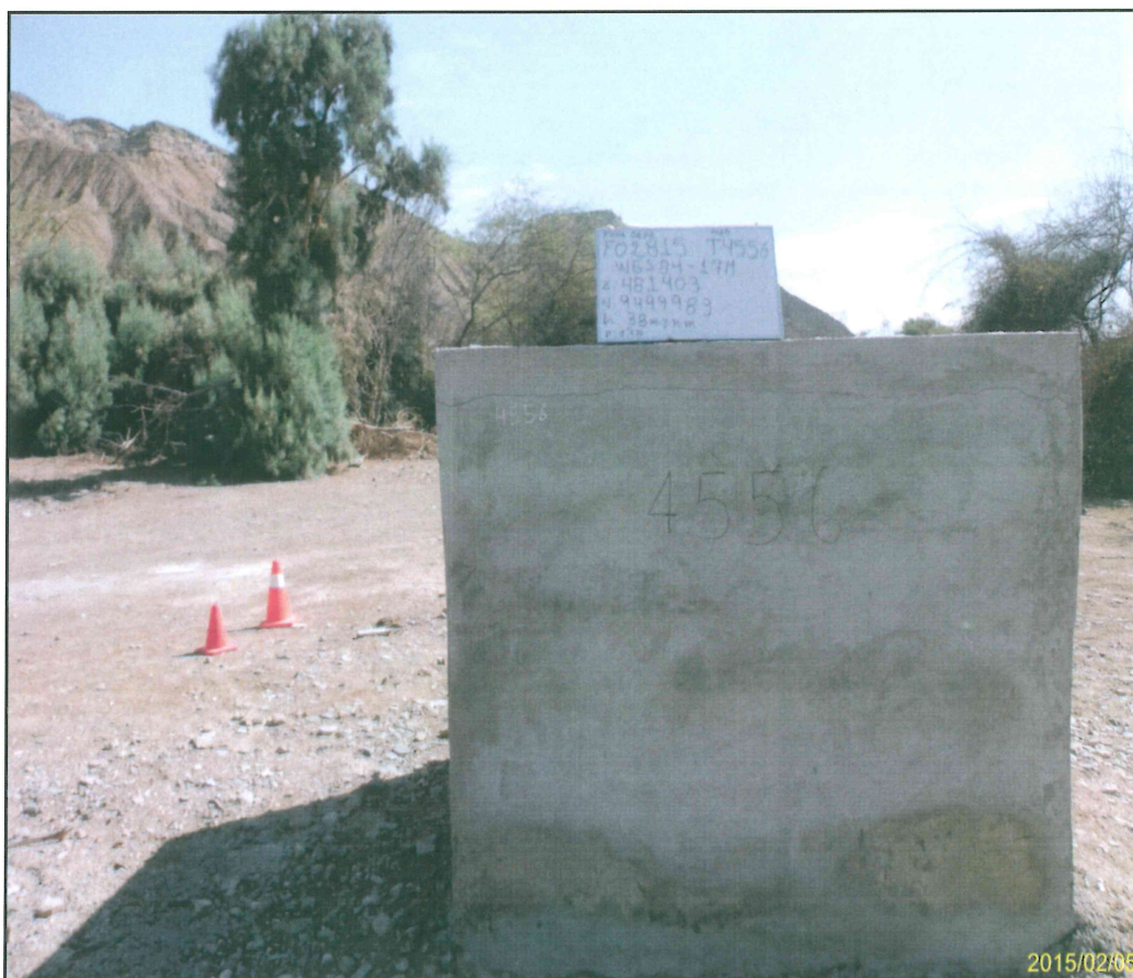
Fotografía N° 1. Estructura de concreto de 1,67 m de altura en cuyo interior se encontraría el casing del pozo con código PERUPETRO T4556.
