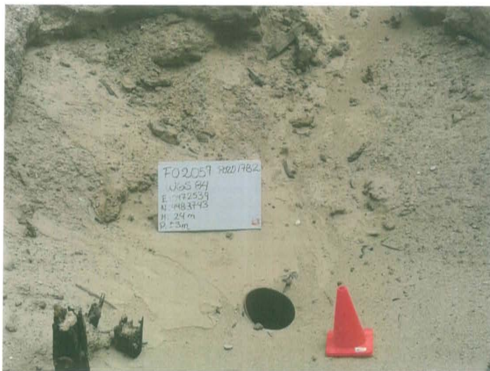
Fotografía N° 1. Identificación del pozo inactivo con código PERUPETRO T1782. Presenta casing abierto al medio ambiente.
