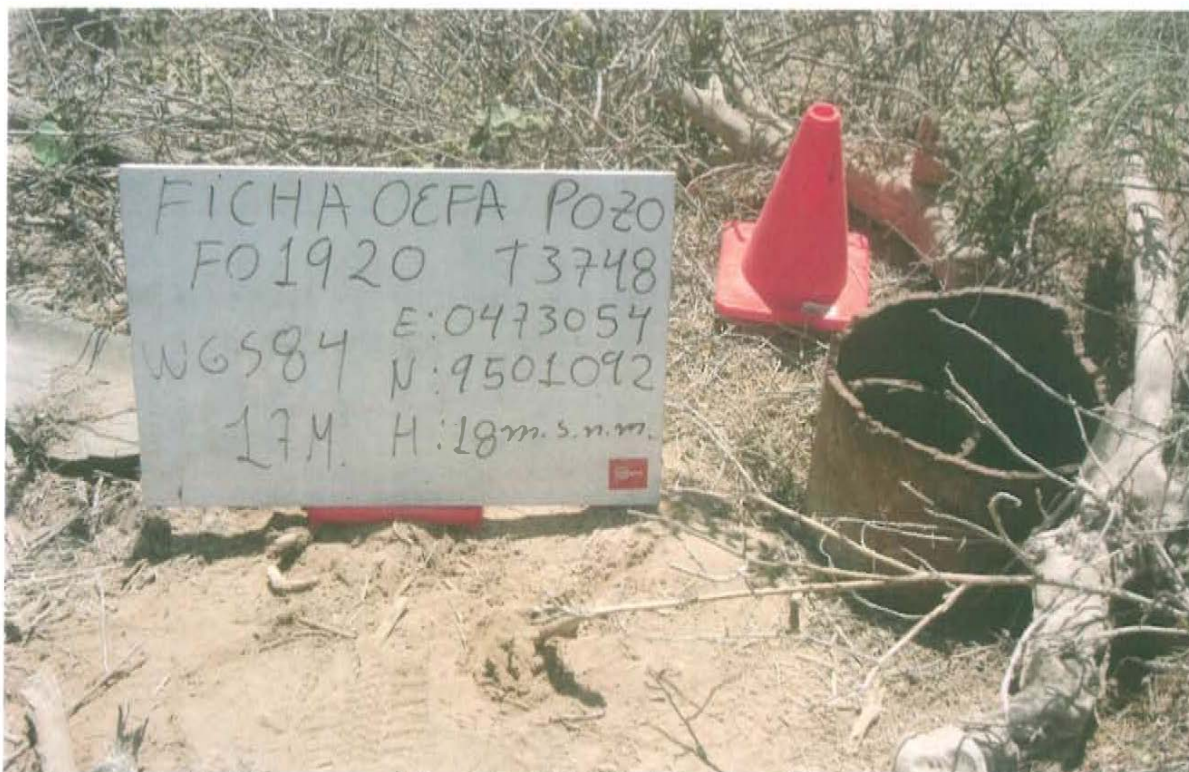
Fotografía N° 1. Pozo con código PERUPETRO T3748 y código Ficha OEFA F01920, se observa el casing corroído con una tubería en su interior, las cuales se encuentran abiertas al ambiente.
