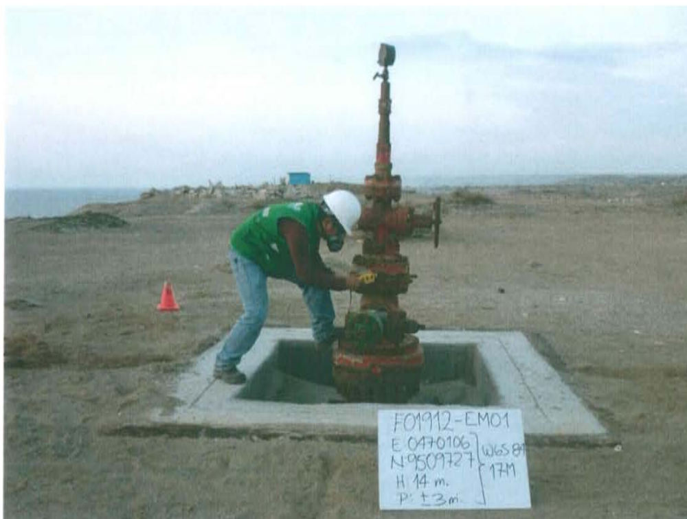
Fotografía N° 4. Medición en el punto F01912-EM01, ubicado en la fuente de emisión en boca del Pozo D_4_P.
