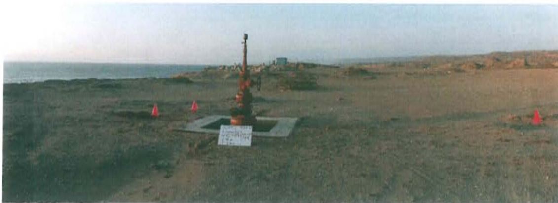
Fotografía N° 2. Vista panorámica del área circundante del pozo inactivo D_4_P.
