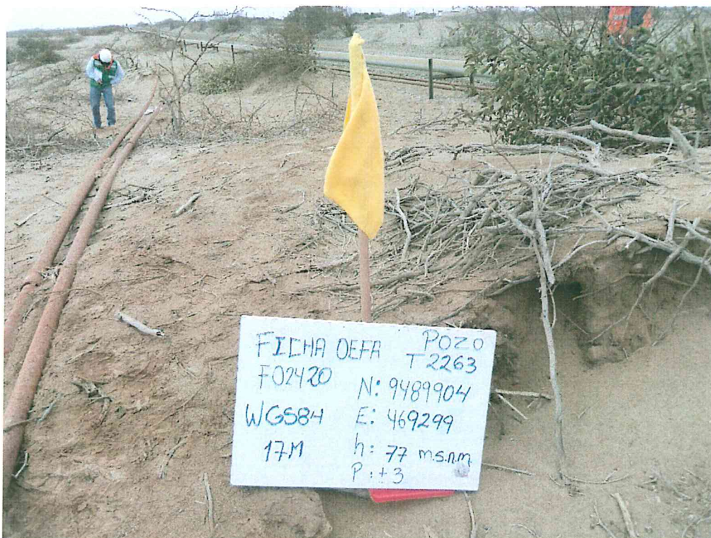
Fotografía N° 1. Pozo T2263 no ubicado superficialmente y que se encontraría enterrado, se observa suelo con hidrocarburos, ducto y tubería de transporte de hidrocarburos hacia una batería (instalada posterior al registro OSINERGMIN).
