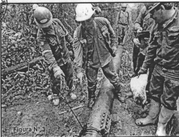
Figura N° 3 y 4: En la foto izquierda se observa el punto de corte de la tubería y la salida del hidrocarburo debido a la presión interna del ducto; en la figura derecha se aprecia toma de muestra de suelo.
