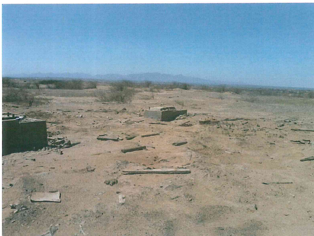
Fotografía N° 2. Vista de la instalación de producción inactiva mal abandonada correspondiente a la ficha OEFA F00572, se observa dos bases de concreto separadas de modo equidistante.
