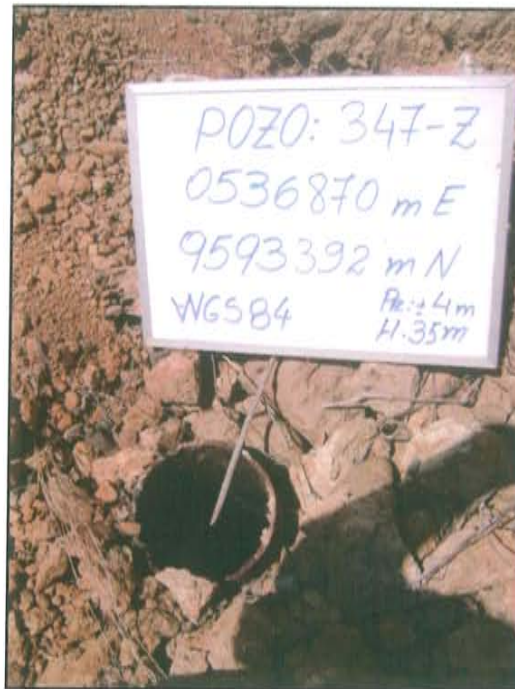
Fotografía N° 1. Se observa un pozo inactivo, con casing cortado al raz del suelo, sin cabezal ni válvulas.
