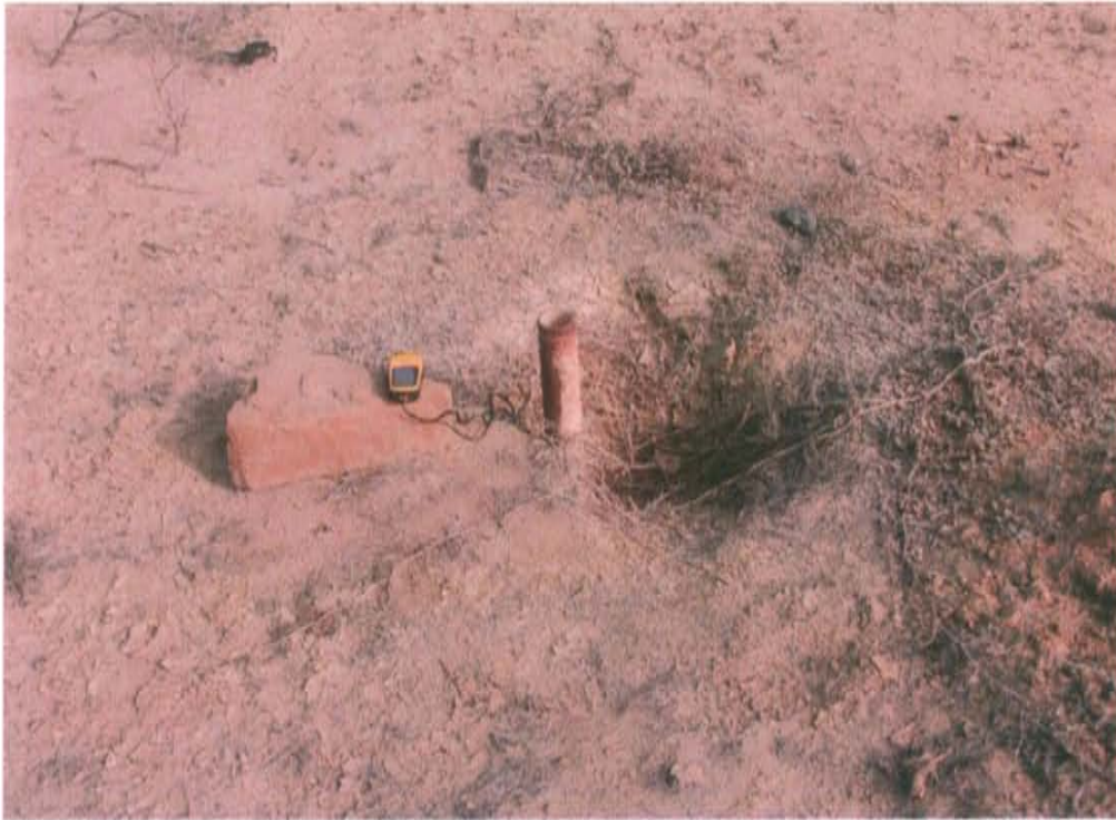
Fotografía N° 1. Pozo L2291 cuenta con un tubo metálico abierto, corroído y sin ningún elemento de cierre que demuestre hermeticidad.
