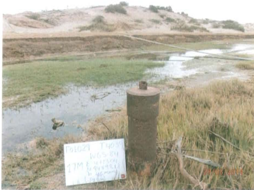
Fotografía N° 1. Pozo inactivo, se observa el casing de 1 m de altura sobre la superficie de suelo.
