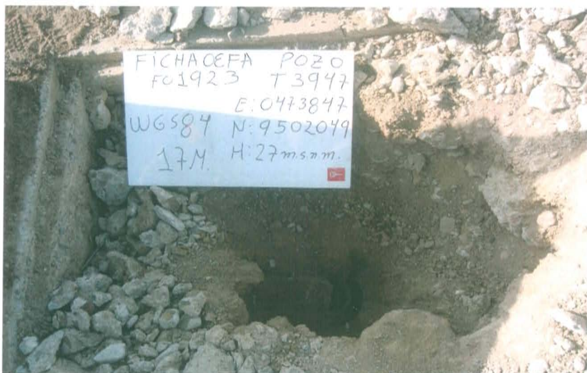
Fotografía N° 1. Pozo con código PERUPETRO T3947 y código Ficha OEFA F01923, se observa el casing dentro de una cantina con una tubería en su interior abiertas al ambiente.
