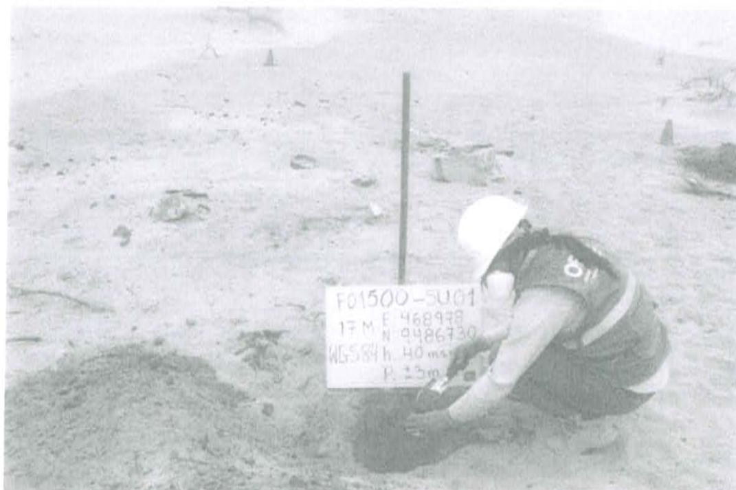
Fotografía N° 1. Toma de muestra de suelo en el punto F01500-SU01, ubicado a 4 m aproximadamente del Pozo T_782.
