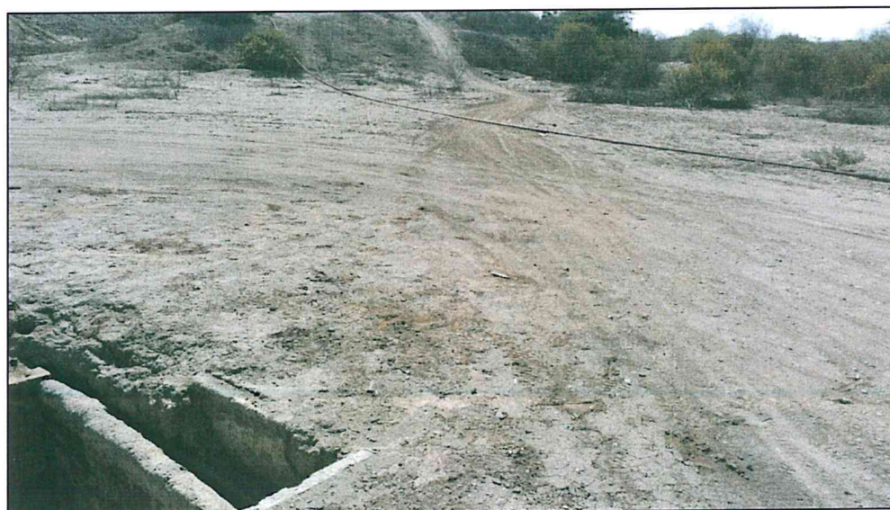
Fotografía N° 4. Vista de la línea de conducción de hidrocarburos existente al lado este del Pozo Pozo T5106.
