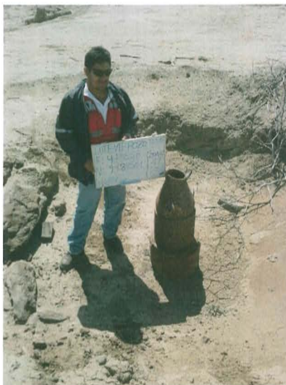
Fotografía N° 1. Vista del pozo T2316, se observa el casing corrido y abierto al ambiente.
