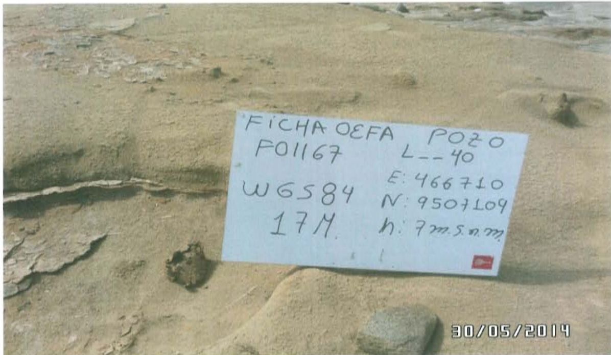
Fotografía N° 01.- Pozo con código PERUPETRO L__40 y con Ficha OEFA F01167, se observa el casing corroído y deteriorado, sin cabezal o alguna válvula de cierre por lo que se encuentra expuesto al ambiente.
