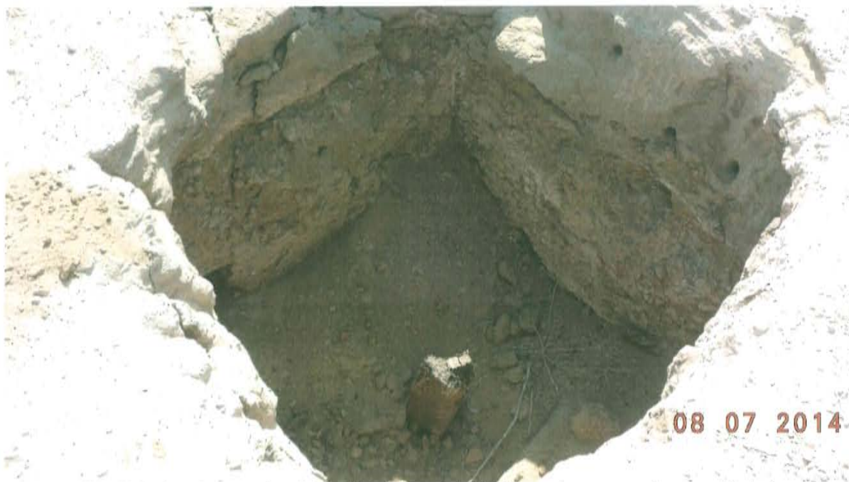
Fotografía N° 2. Se observa la ubicación del pozo T1765 que se encuentra en el interior de un hoyo, dentro del cual se ubica una viga de madera que bloquea parcialmente la boca de pozo.
