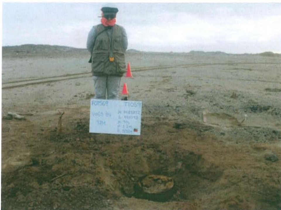
Fotografía N° 2. Luego de una pequeña excavación se observa el casing en estado avanzado de corrosión y con el interior lleno de arena.
