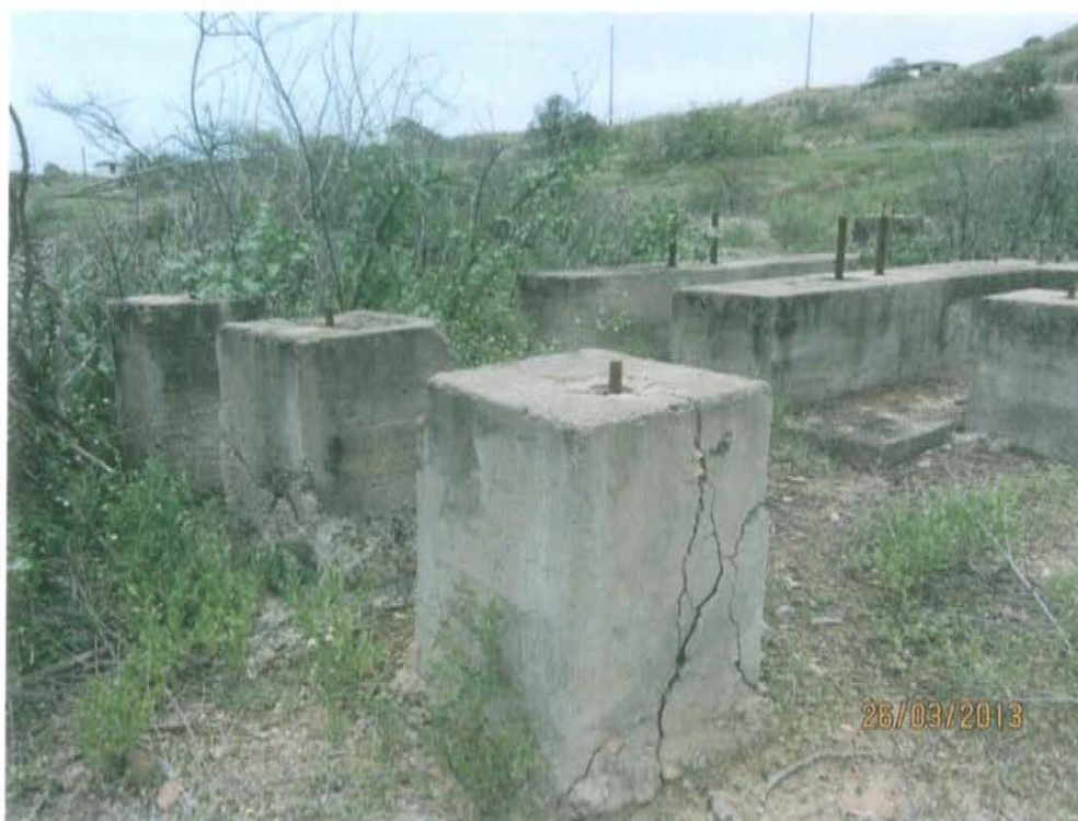
Fotografía N° 1. Se observa estructuras de concreto donde posiblemente se ubicarla el Pozo P__2.
