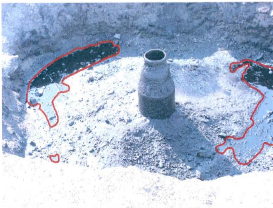
Fotografía N° 3. Se observa pozo abierto y expuesto al ambiente, donde se observa suelo con hidrocarburos e hidrocarburos líquidos a la intemperie.
